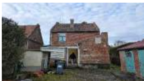
façade de l'existant sur jardin
