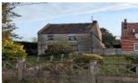
Façade de l'existant sur rue
