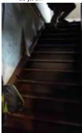
L'escalier d'accès à l'étage
